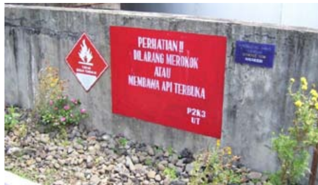
Gambar 18 Pemasangan peringatan daerah mudah terbakar
