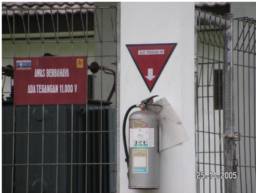
Gambar 20 Contoh APAR dan Penempatannya
