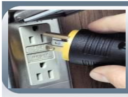
Gambar 8 Peralatan listrik menggunakan kabel tiga kawat/three-wire cord dengan kontak yang tergrounding
