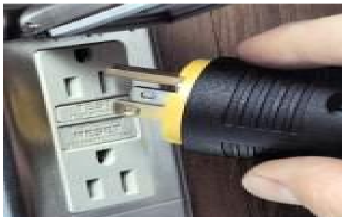
Gambar 15 Gambar peralatan yang mempunyai grounding yang benar
